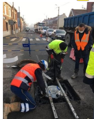
Renouvellement de 2 Tampons sur la RD 941
